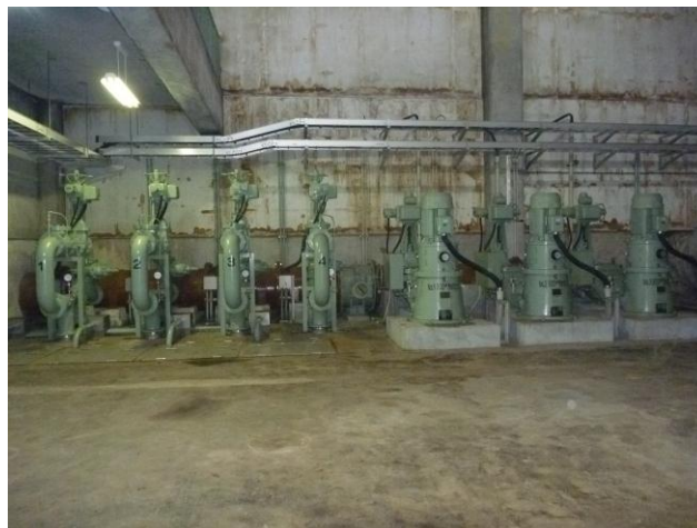
図 5.4 増強したポンプの状況
