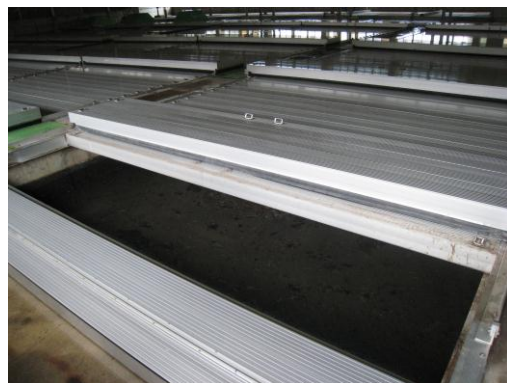
滞水池内部(雨天時汚水流入状況)
