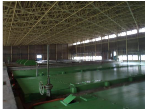
既設系水処理施設の内部の状況
