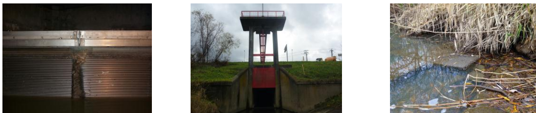
図 6.1 スクリーンの設置状況と放流先の状況
