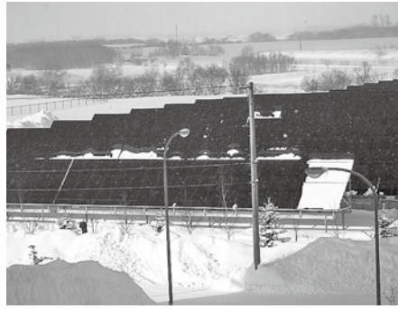
江別ノーザンフロンティア発電所
