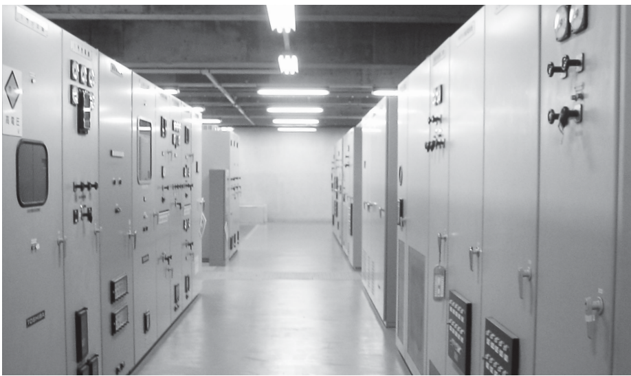
写真1 / 受変電設備…江別浄化センターの心臓部となり電気を供給している。
