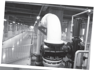
写真/送風機の調整弁…散気装置設備へ送る空気量を調節します。
