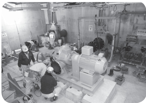
写真/汚水ポンプ…浄化センターへ流入してきた汚水を地上に汲み上げています。
