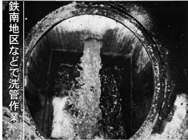
水道水の放水による洗管作業の様子
