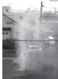
吹き上がるマンホール（平成23年8月26日）
