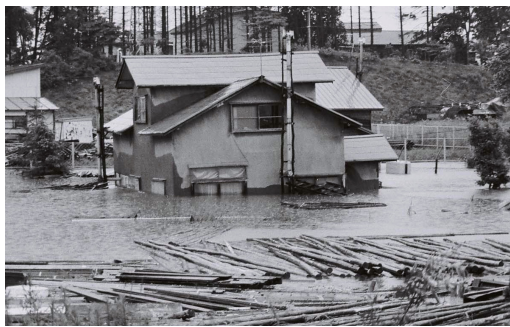
昭和56年の水害。水没した民家。
